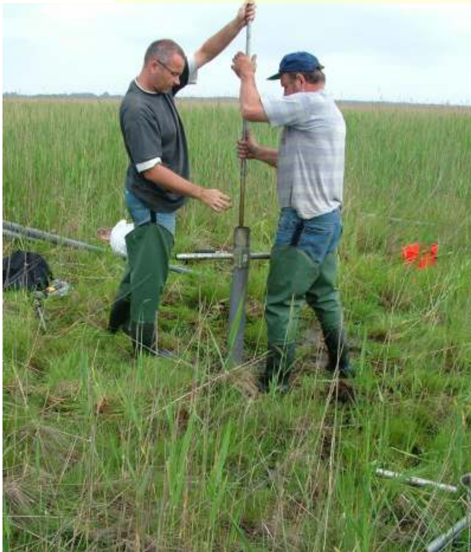
Ręczne wiercenie piezometru
