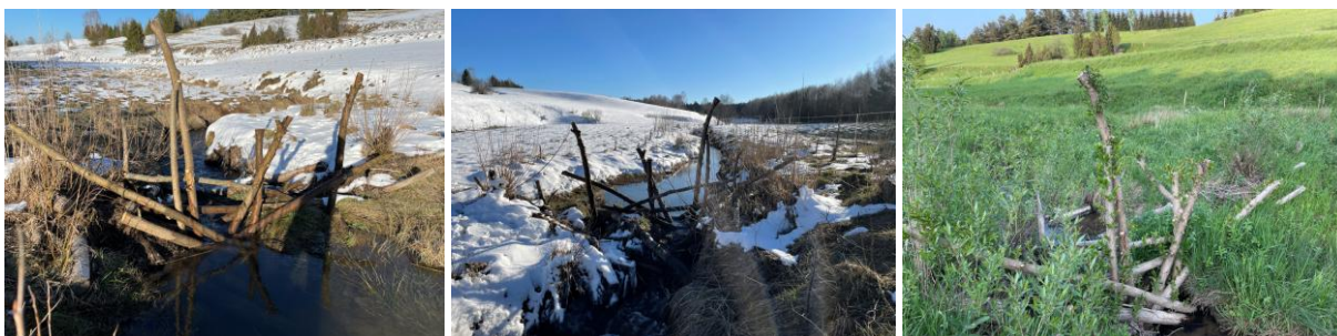
Imitacja tamy bobrowej blokująca rów melioracyjny w Bieszczadach, wykonana z gałęzi wierzbowych - od budowy jesienią do następnego lata. Fot. Andrzej Czech.
