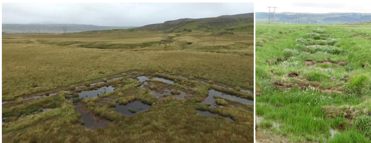
W obszarze Sogn (Islandia) zastosowano mieszane metody odtwarzania uwodnienia (zdjęcie po lewej, fot. Sunna Áskelsdóttir). Po prawej (fot. Paweł Pawlaczyk) zablokowany odpływ z islandzkiego torfowiska.
