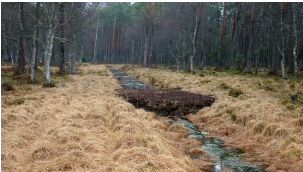
Przykład tamy torfowej. Fot. Paweł Pawlaczyk
