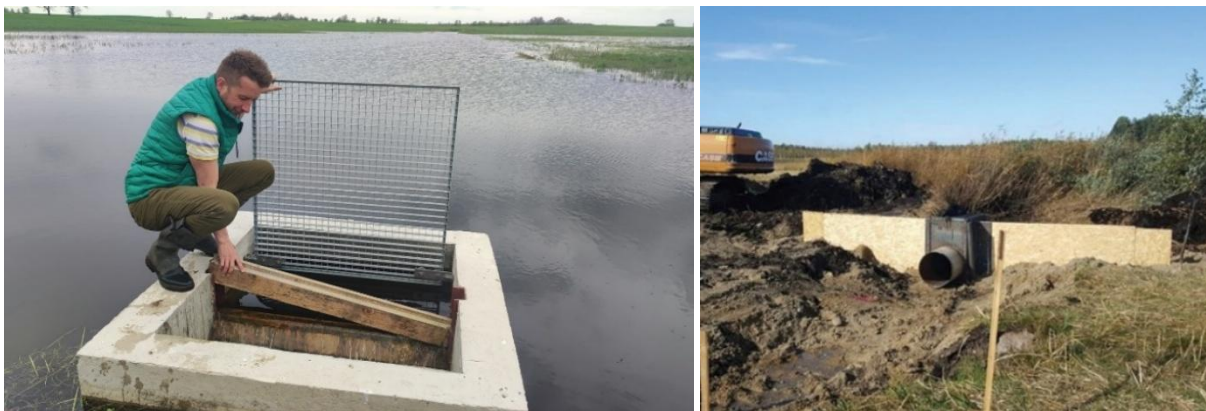
Zastawki z drewnianymi szandorami, które umożliwiają regulację poziomu piętrzenia wody, wykorzystywane są do częściowego nawadniania łąk bagiennych. Fot. Archiwum fundacji „VšĮ Pelkių atkūrimo ir apsaugos fondas”
