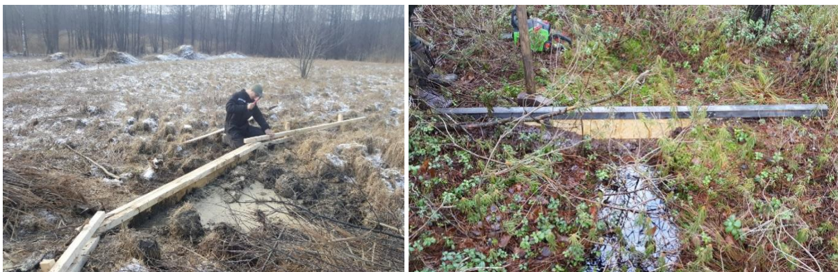
Przegrody wykonane z płyt MDF (po lewej) i OSB (po prawej) są prostym rozwiązaniem w blokowaniu małych rowów. Fot. Archiwum fundacji „VšĮ Pelkių atkūrimo ir apsaugos fondas”
