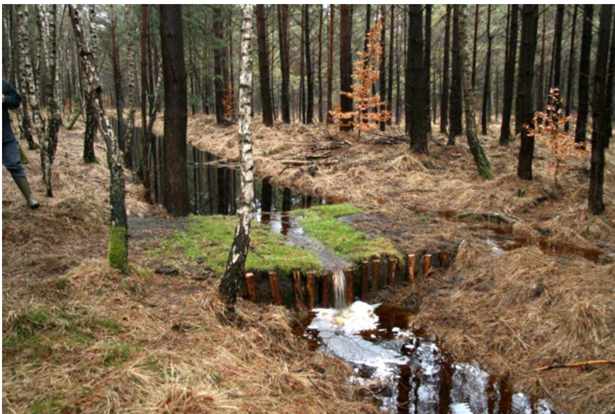
Przykład przegrody z drewna i gliny. Fot. Paweł Pawlaczyk
