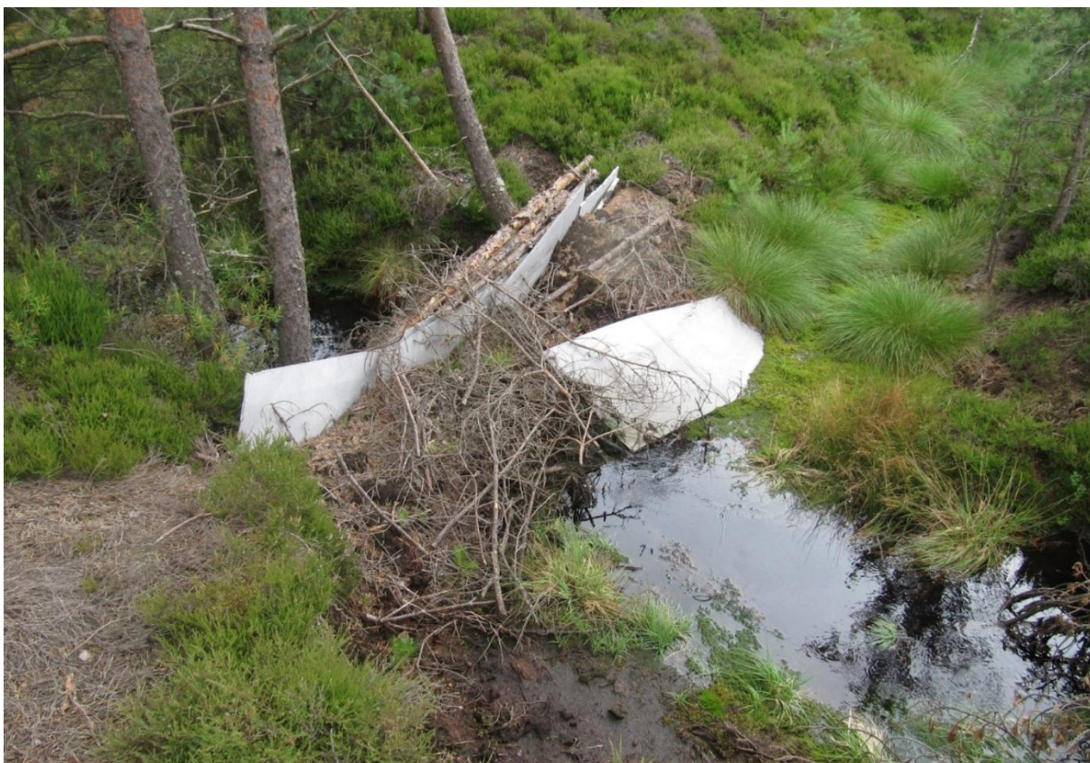
Przegroda wykonana ad hoc na torfowisku Puścizna Wielka na Orawie, przez właściciela kopalni torfu, któremu nakazano ograniczenie oddziaływania. Chwilowo skuteczna, choć problematyczna estetycznie; została szybko rozmyta przy wiosennych roztopach. Fot. Paweł Pawlaczyk
