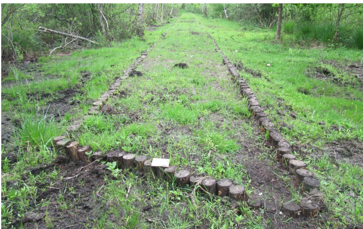
Przegroda torfowa wzmocniona elementami drewnianymi. Fot. Paweł Pawlaczyk
