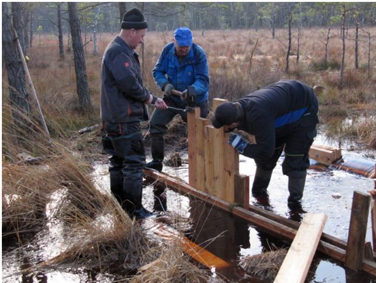
Blokowanie rowów na w ramach ochrony torfowisk bałtyckich.
