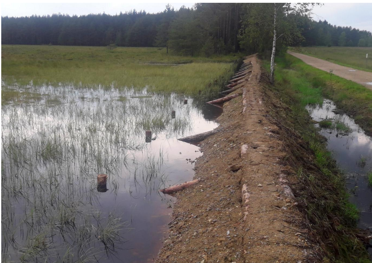
Grobla wykonana przez Fundację Przyroda i Człowiek dla zatrzymania wody na torfowisku Bór na Czerwonym na Orawie. Fot. Paweł Pawlaczyk
