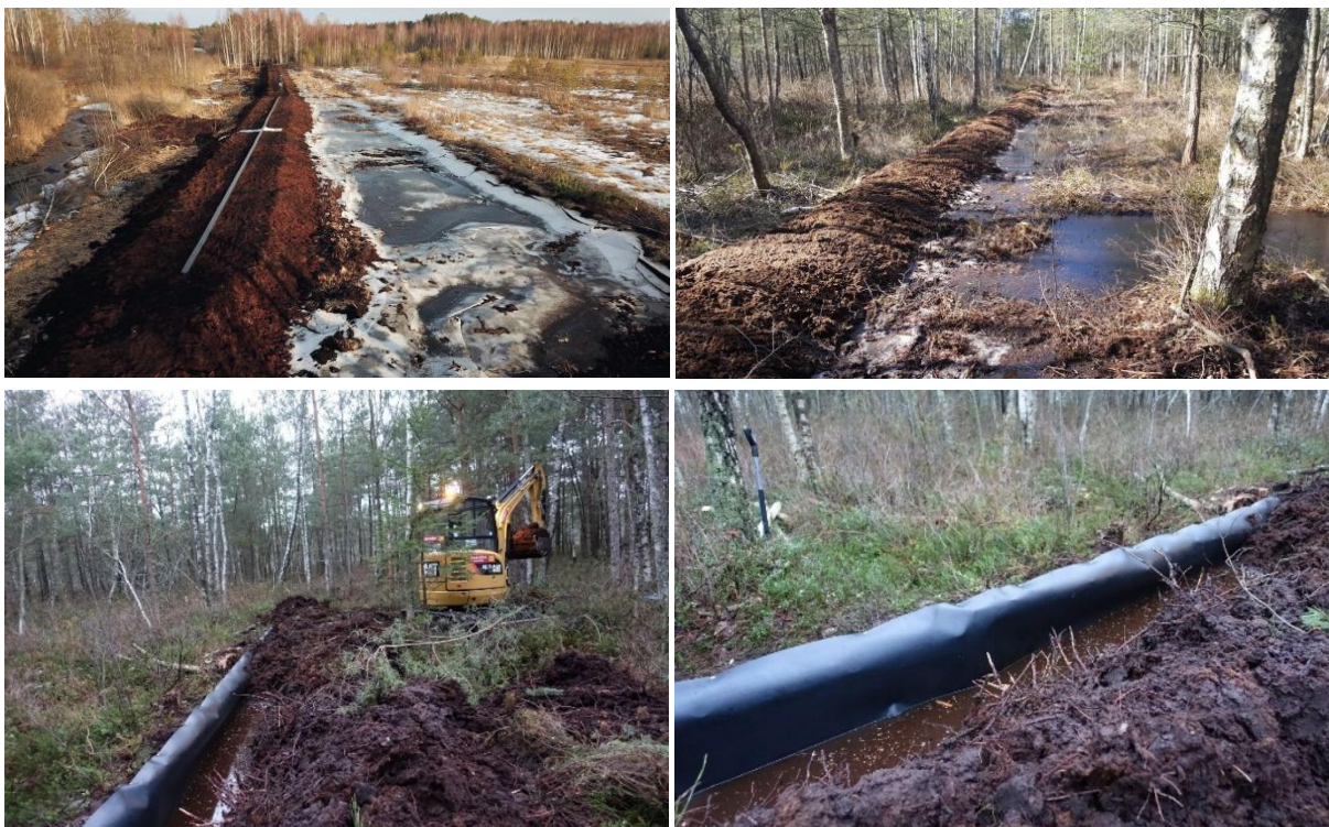
Groble wybudowane z pozostałości torfu hamują powierzchniowy odpływ wody. Fot. Archiwum fundacji „VšĮ Pelkių atkūrimo ir apsaugos fondas”
