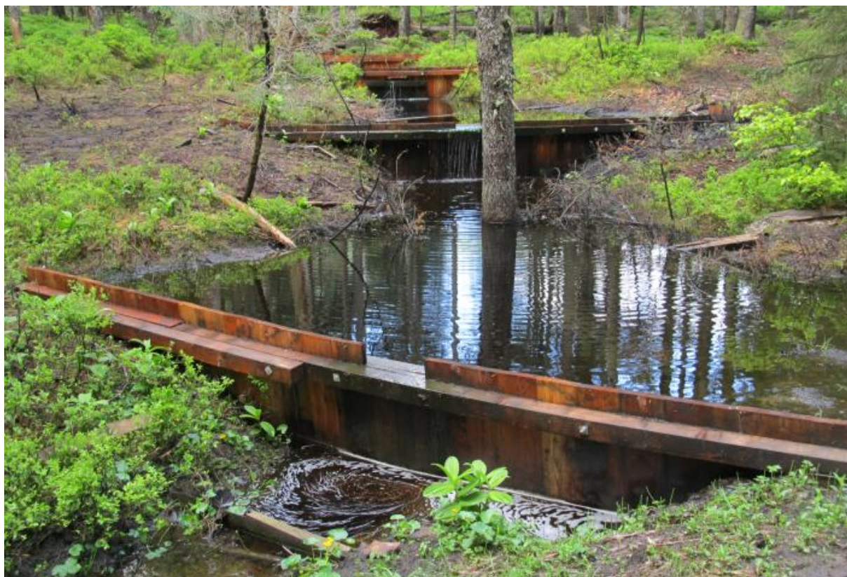
Metoda „kaskadowa” blokowania rowów stosowana jest także w innych krajach. Renaturyzacja torfowisk w Alpach Austriackich. Fot. Paweł Pawlaczek
