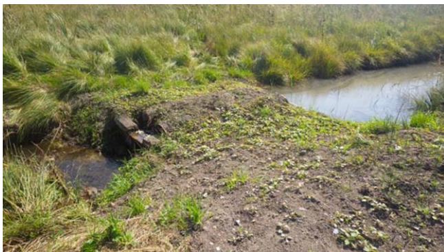
Przykład przepustu dławiącego. Fot. Dorota Horabik
