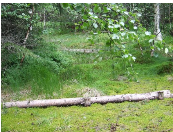
Blokowanie spływu powierzchniowego na torfowisku górskim za pomocą kłód drewna. Fot. Andrzej Jermaczek.
