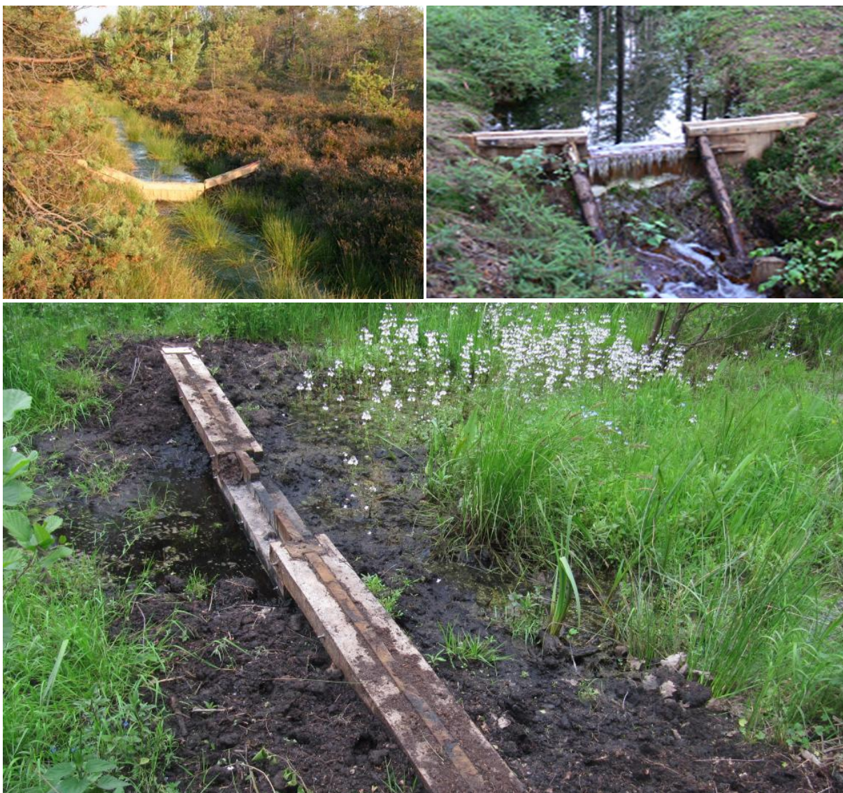
Przykłady stałych przegród drewnianych. Fot. Paweł Pawlaczyk
