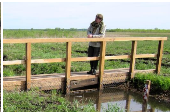
Przykład regulowanej zastawki. Fot. Paweł Pawlaczyk
