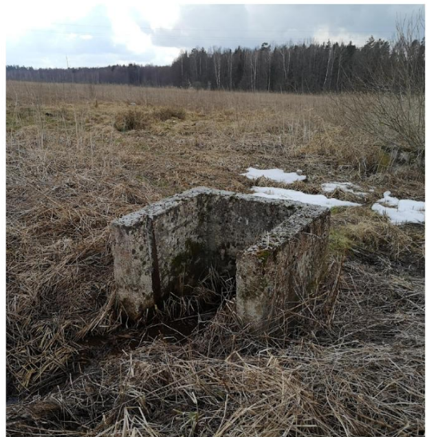
Apleisti hidrotechniniai statiniai, anksčiau naudoti vandens lygiui reguliuoti nusausintuose durpynuose, Narevo (lenk. Narew) ir Sokoldos (lenk. Sokółda) upių slėniuose, Palenkės (Podlaskie) vaivadija. Michał Korniluk nuotr.
