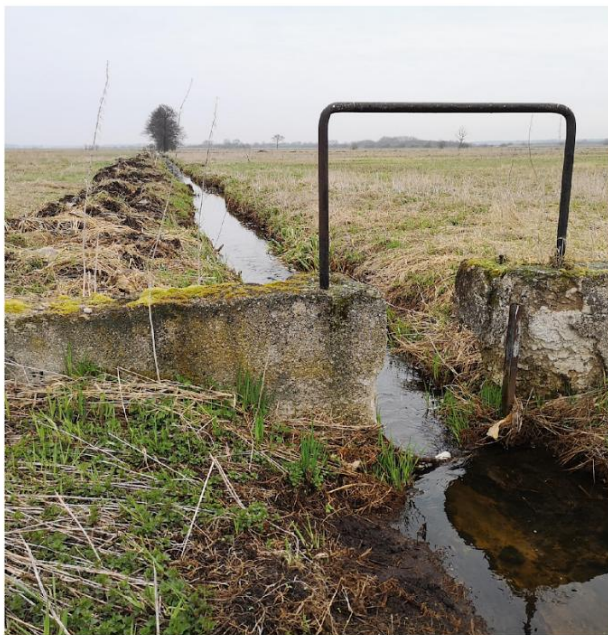
Apleisti hidrotechniniai statiniai, anksčiau naudoti vandens lygiui reguliuoti nusausintuose durpynuose, Narevo (lenk. Narew) ir Sokoldos (lenk. Sokółda) upių slėniuose, Palenkės (Podlaskie) vaivadija. Michał Korniluk nuotr.
